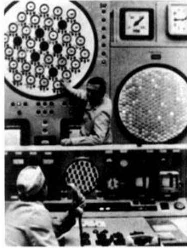
第一座核电站的控制室
