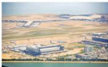
图 7.33 填海造地建成的香港机场
