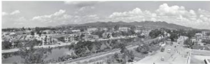
建设中的深圳市区（1980年）
