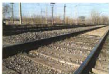
图 3-4 用锰钢（一种合金钢）制成的钢轨
