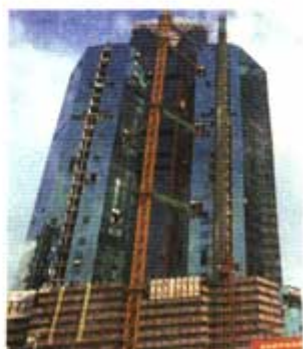
图 3-31 钢筋混凝土常用来建造高楼大厦
