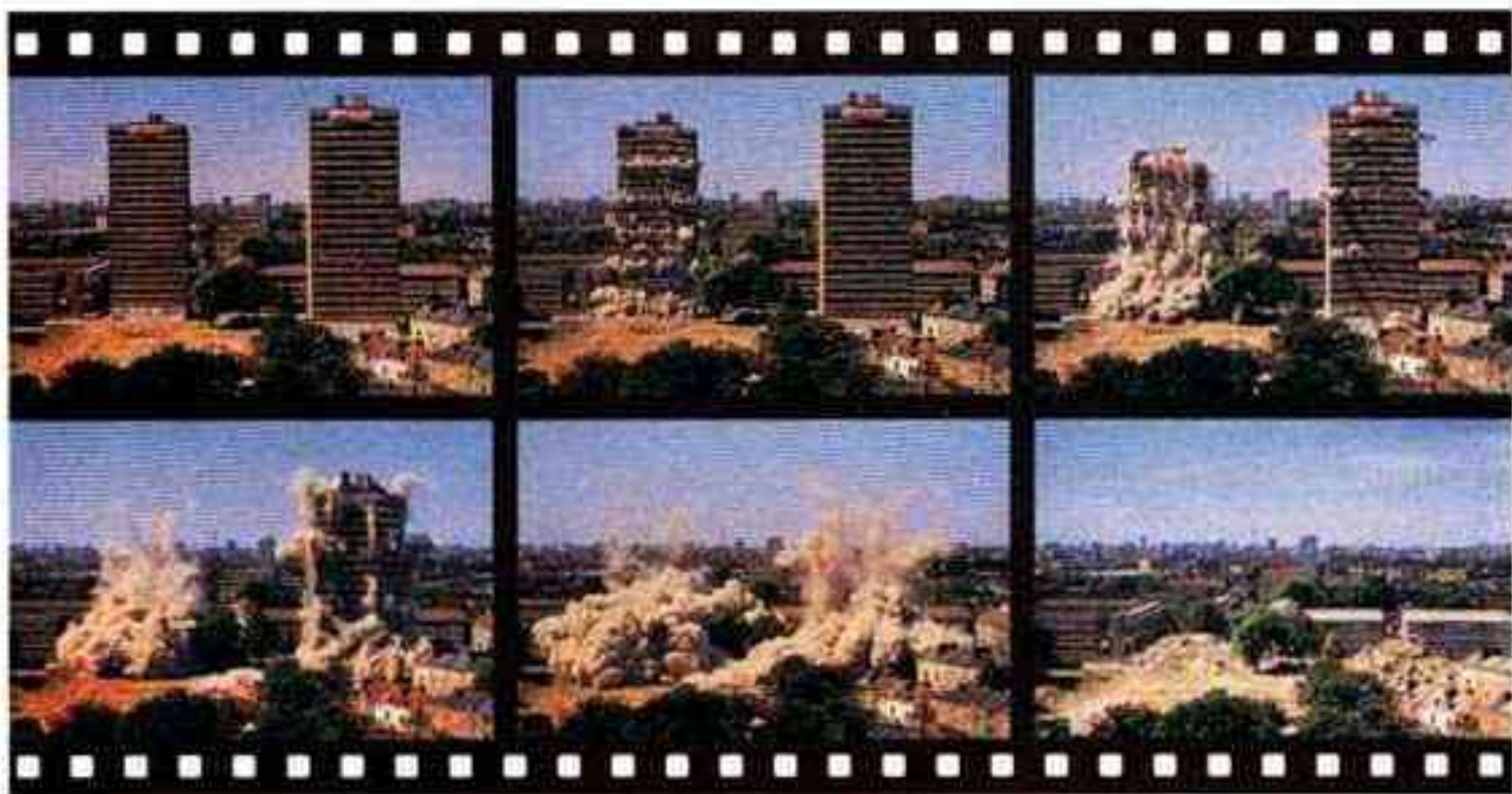
图 2-20 建筑物的定向爆破
