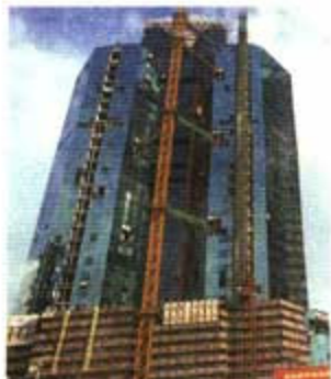
图 3-31 钢筋混凝土常用来建造高楼大厦
