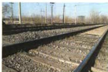
图 3-4 用锰钢(一种合金钢)制成的钢轨
