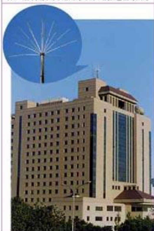
图 1.1-11 现代避雷针往往具有很多组金属尖棒，做成蒲公英花的形状以增强避雷效果。
