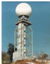
图 14.4-6 一些雷达天线外面装有球形防护罩。防护罩由能够透过无线电波的材料制成。
