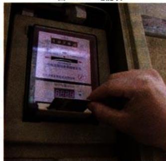
图 7.1-4 IC卡电能表
