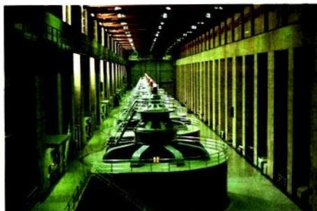
图8.5-5 现代水力发电厂中的发电机组。发电机的轴是竖直安装的,轴的下面连接着水轮机,在强大水流的冲击下旋转。
