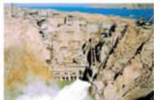
龙羊峡水电站
