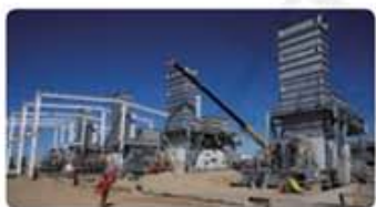
西气东输二线建设
