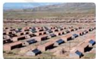
三江源地区移民安置工程
