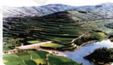
治理水土流失的工程措施 在沟谷兴修小型水库、打坝淤地，在坡面修建梯田等。
