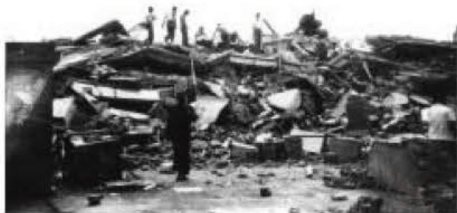
图2-3-7 唐山大地震造成的破坏 1976年7月28日发生在河北省唐山市的7.8级地震，使这个百万人口的工业城市顷刻间成为一片废墟。
