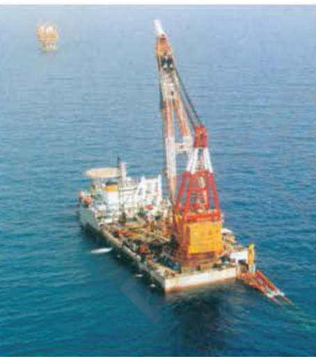
图 4-1-3 海底管道铺设作业
