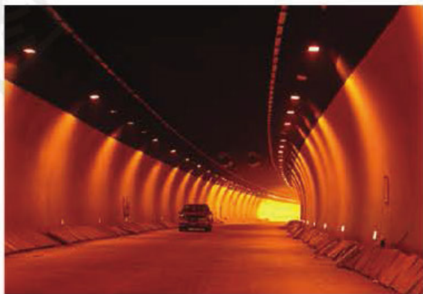
图 4-2-16 穿越黄山景区的生态公路隧道
