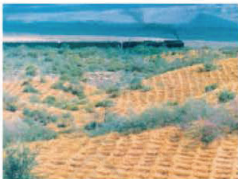
图3-2-21 沙坡头治沙的草格沙障
