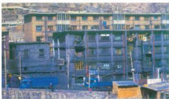
图2-2-2 煤在运输过程中对环境的污染 这是山西省大同煤矿集团七矿区运煤公路旁的家属楼，越靠近路边的家属楼外表越黑。
