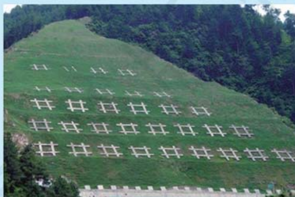
图 3-2-5 贵州省鹅山冲滑坡治理
