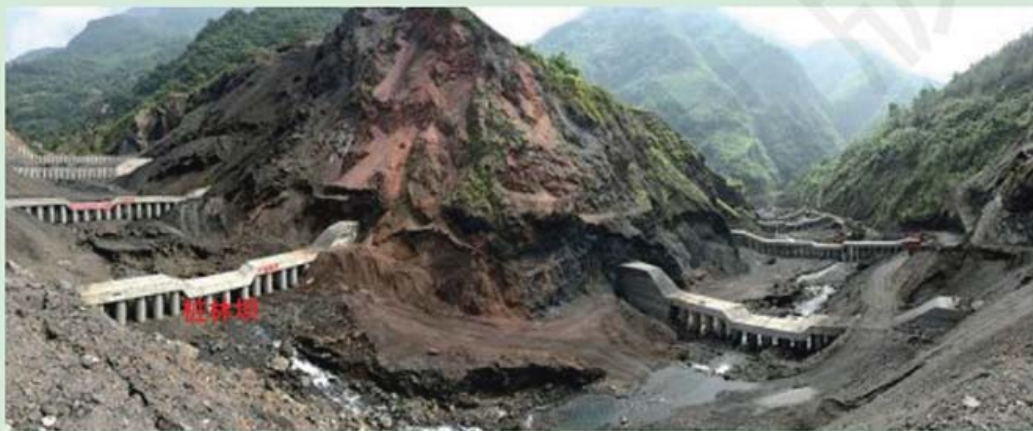
图 3-2-1 都坝河上游物源区建造的桩林坝
