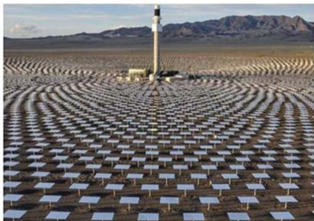
太阳能光热电站
