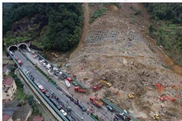
图 3-1-5 2015 年 11 月浙江丽水山体滑坡现场
