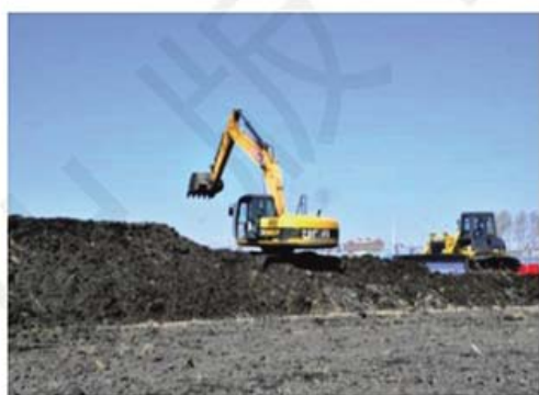
2017—2018 年，黑龙江农垦三江管理局共实施表土剥离项目 21 个，剥离土方量 45 万立方米，改造中低产田近千亩，预计每亩可增产水稻 150 千克。
