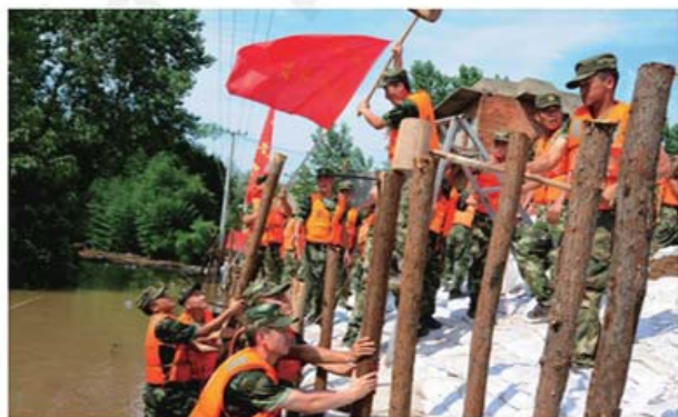
图 3-2-8 参加抗洪救灾的解放军战士在打桩加固堤坝
