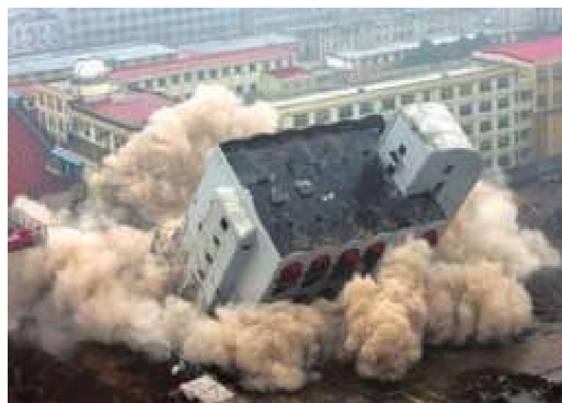
图7-17 利用炸药爆破拆除楼房
