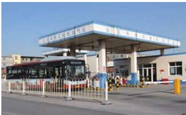
图7-38 压缩天然气汽车加气站
