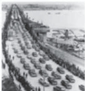
④ 1957年，长江上第一座铁路和公路两用大桥——武汉长江大桥建成。
