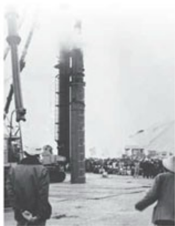
上海宝钢工程打下第一根钢管桩
