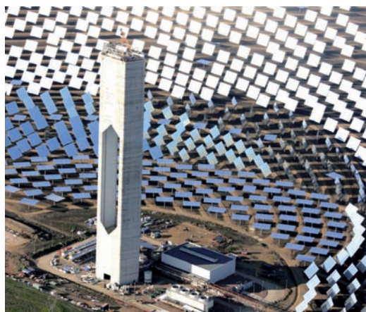
图4.3-5 塔式太阳能电站
