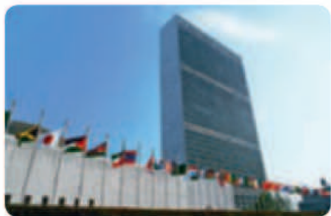
位于美国纽约的联合国总部大楼
