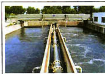
曝气沉沙池：使沙、水初步分离
