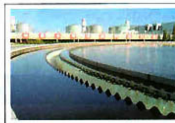
二次沉淀池：经过曝气池出来的水在此进行二次沉淀
