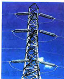
铝导线用于高压输电
