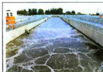
曝气池：通过微生物的代谢作用，将污水中各种复杂的有机污染物降解为简单的、无害的物质
