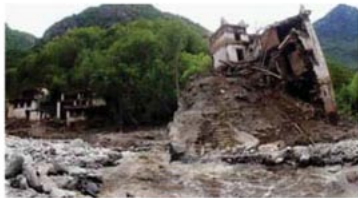
图 5.10 被泥石流冲垮的丹巴民居
