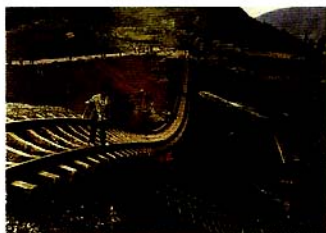
图 2.14 滑坡冲毁铁轨
