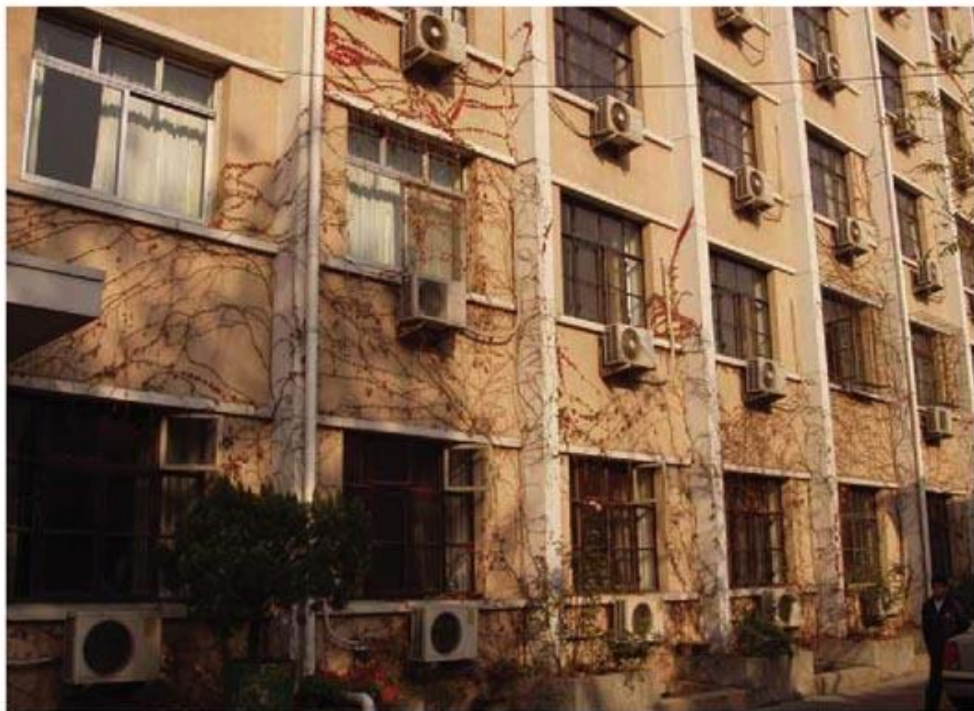
装有空调的楼房
