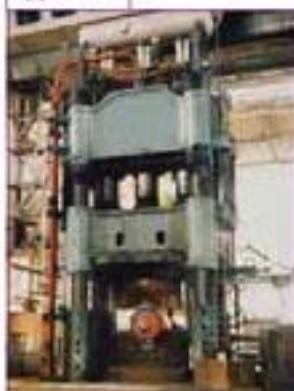
甲 水压机正在锻压工件
