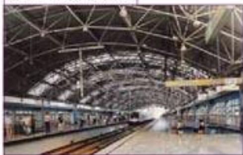
图 2.3-7 网架结构车站
