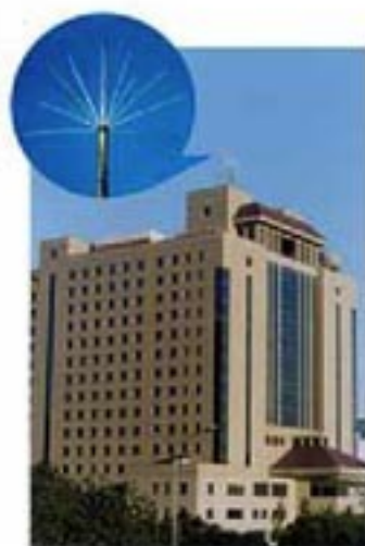
图 1.7-4 现代避雷针往往具有很多组金属尖棒，做成蒲公英花的形状，以增强避雷效果。
