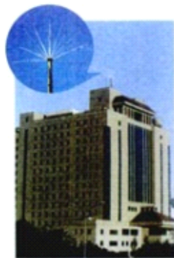
图 1.7-3 现代避雷针往往具有很多组金属尖棒，做成蒲公英花的形状，以增强避雷效果。
