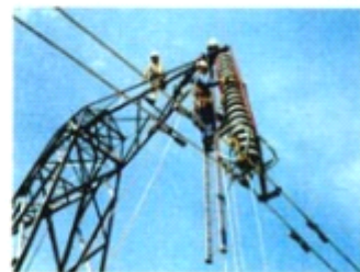
图 1.7-11 超高压带电作业的工人所穿衣服的织物中掺入了金属丝
