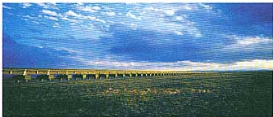
青藏铁路路基上专供野生动物行走的涵洞
