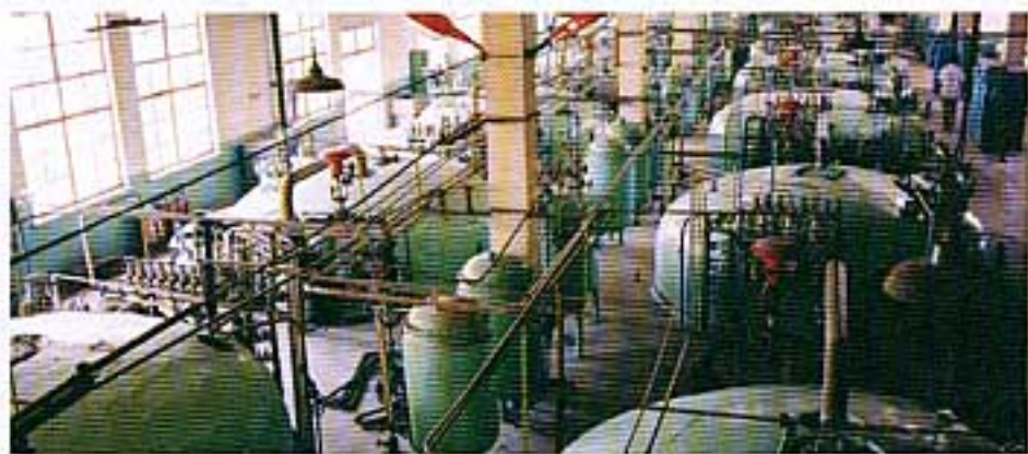
图3-3 我国某制药厂的发酵生产车间
