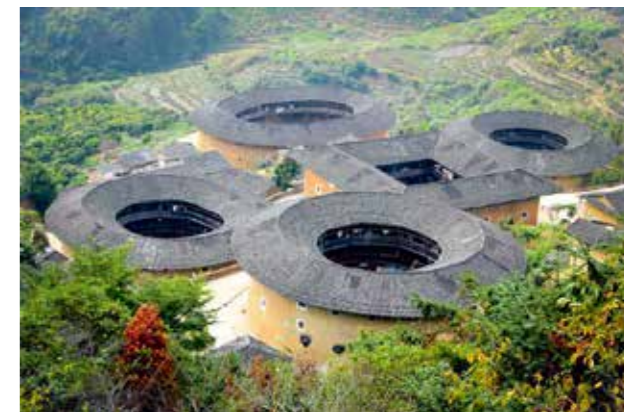
福建土楼外景
