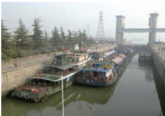
图 4-23 葛洲坝 2 号船闸
