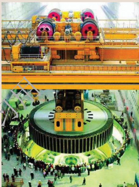
图14-57 吊装转子
