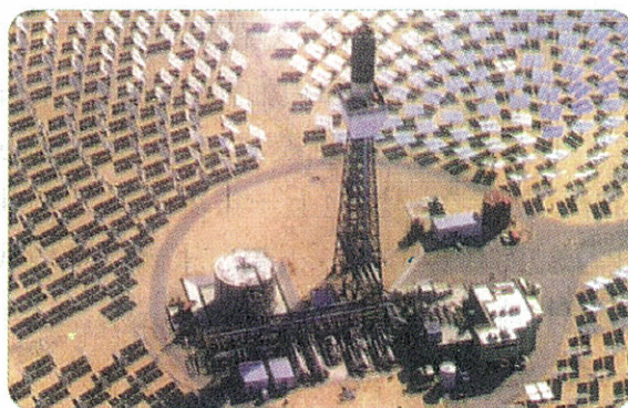
图 1-9 太阳能发电站
