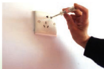
图 9-1-8 用验电笔检验插座的相线
