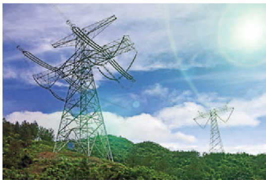
图4 特高压输电线
