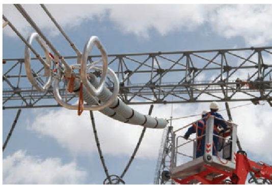
图3 特高压线路铺设
