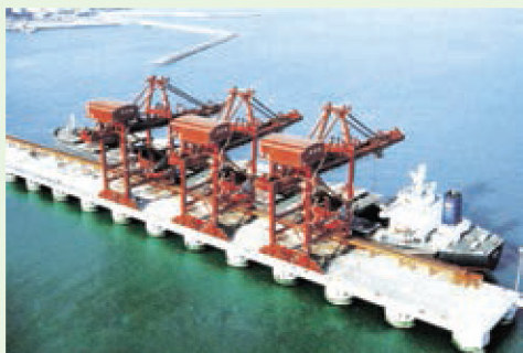
(b) 吊装能力位居亚洲前列、安装在青岛港的卸船机
