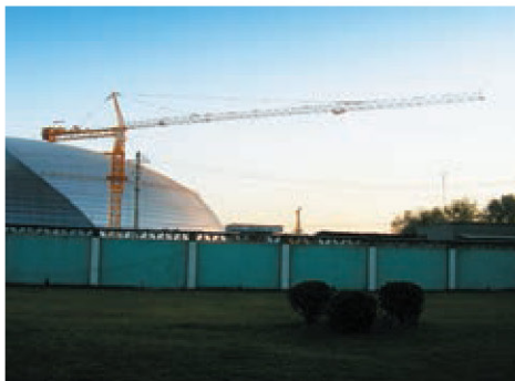
图 11-1-5 塔式起重机的吊臂也是杠杆
