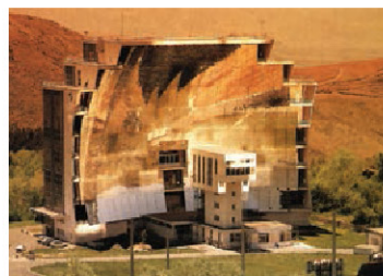
图 5-3-6 太阳能聚光装置
