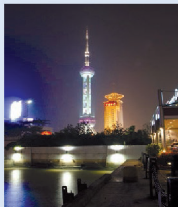
图3-2-10 上海东方明珠电视塔的景观照明采用的是LED灯光系统
