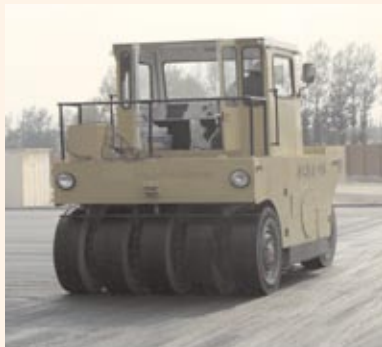
图3-18 压路机压路面
