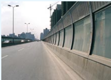
图2-34 高架路上安装隔音屏
