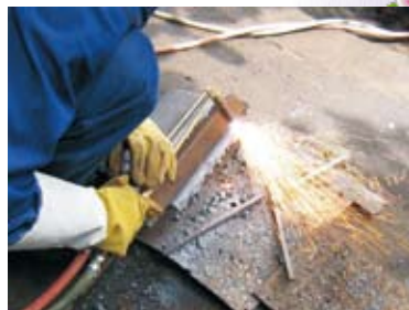
图3-7 燃料在氧气中燃烧后产生的高温火焰可用于来切割或焊接金属
