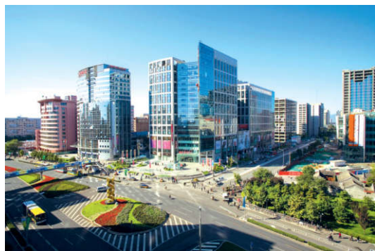
图 8-17 北京中关村科技园区
