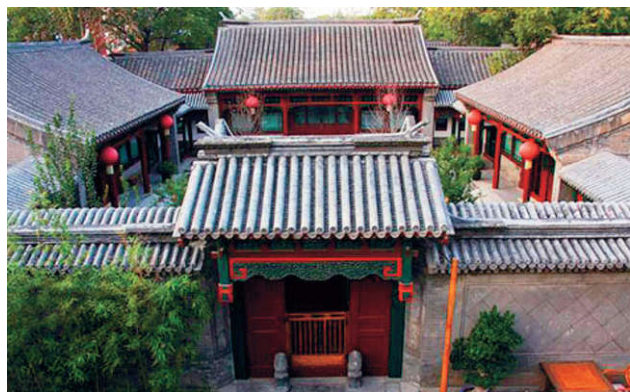
北京四合院是中国北方典型的民居建筑，院落宽敞别致，日常起居方便。
