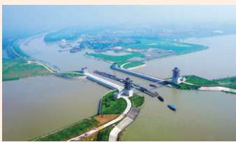
图 5-3 淮安枢纽工程
