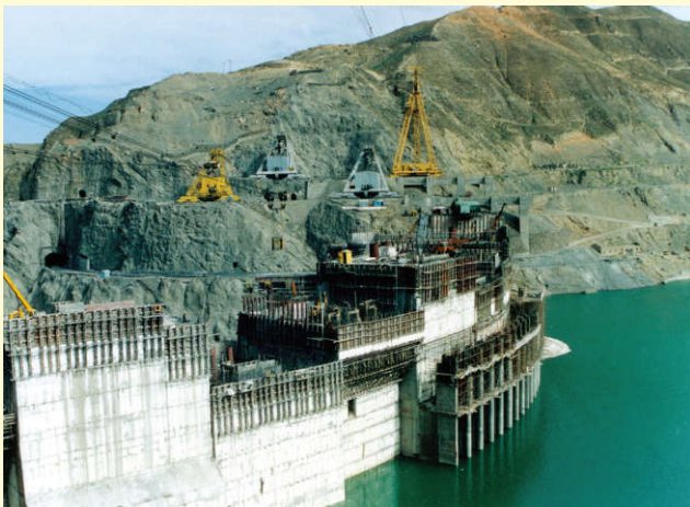
图 1-24 李家峡水电站
