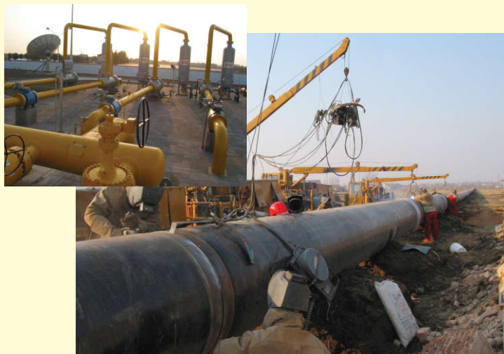
图 1-22 西气东输工程建设现场
