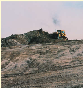
图 2-11 平整矿区土地
