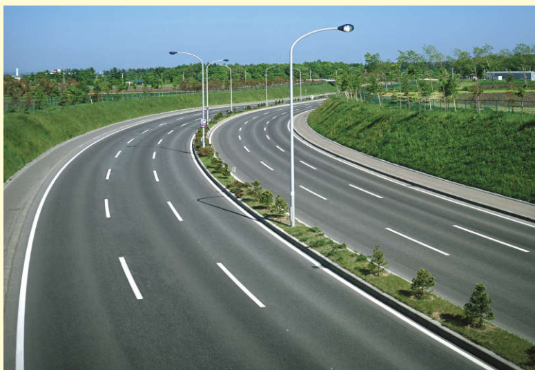
图 3-13 修复后的高速公路沿线的生态环境
