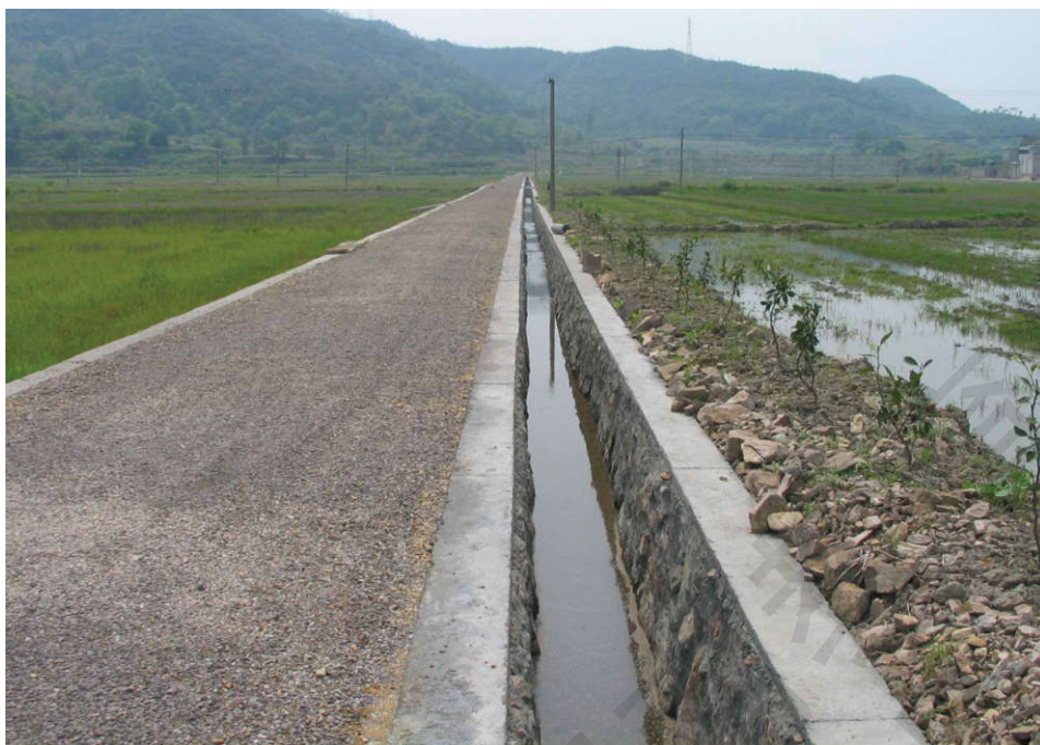
图 2-20 农田经过土地整理后的沟、渠、路
