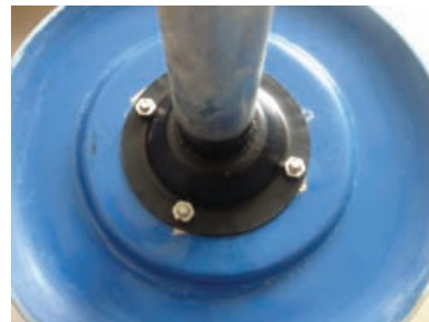
图4-14 螺栓接合
