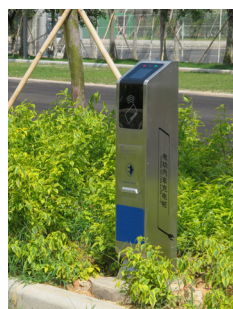
(c) 电动汽车的充电桩
