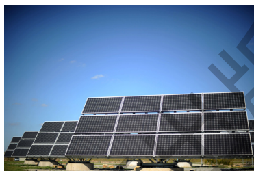
(b) 太阳能发电站利用太阳能电池直接将太阳能转化成电能
