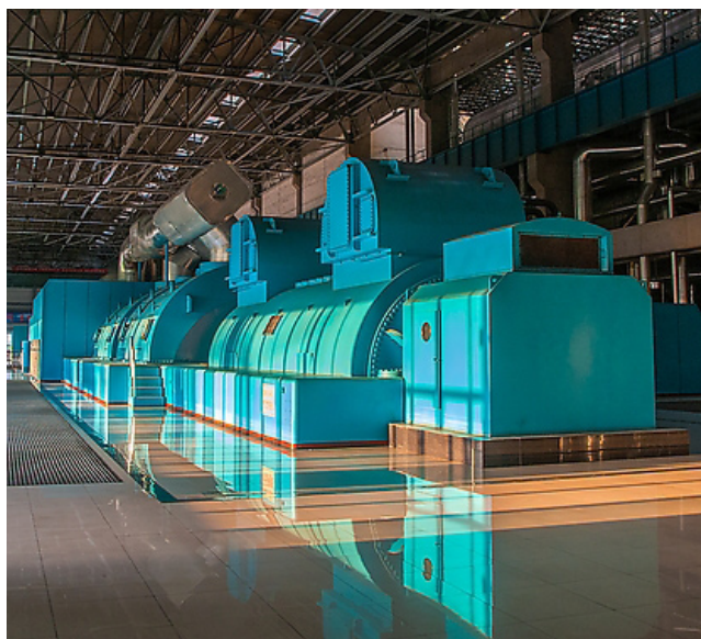
图 17-22 汽轮机利用蒸汽流驱动发电机转子转动
