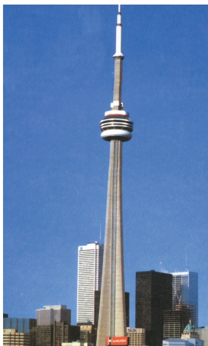
图 3-4-3 高大的电视发射塔
