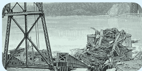
图 1-8 坍塌后的魁北克大桥
