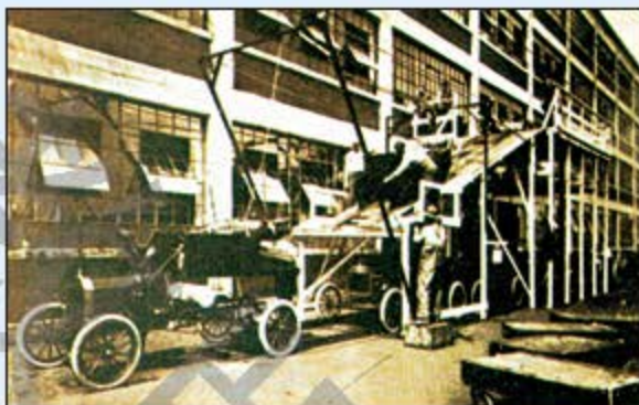
福特T型车的生产流水线
