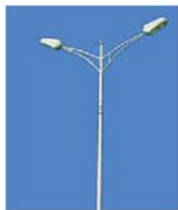
图 4.7-1 悬挂路灯的一种三角形结构
