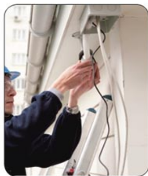
图2.2.5 现场安装设备
