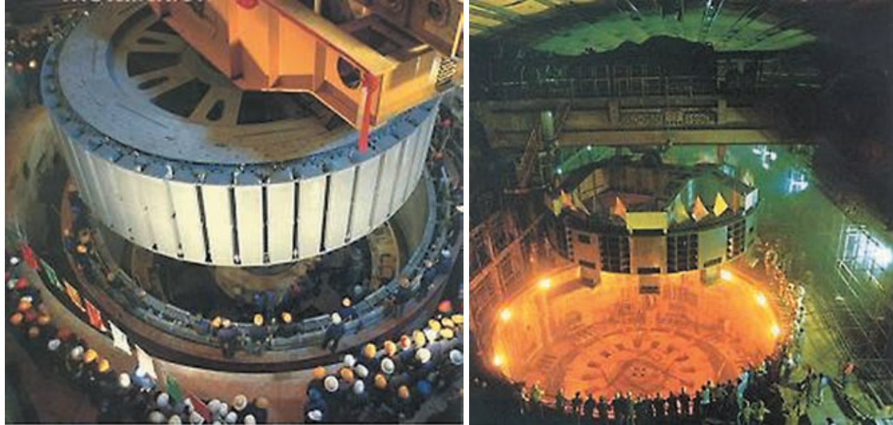
图 2-2 正在吊装的大型发电机的转子和定子
