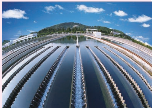
图1-56 自来水厂全貌
